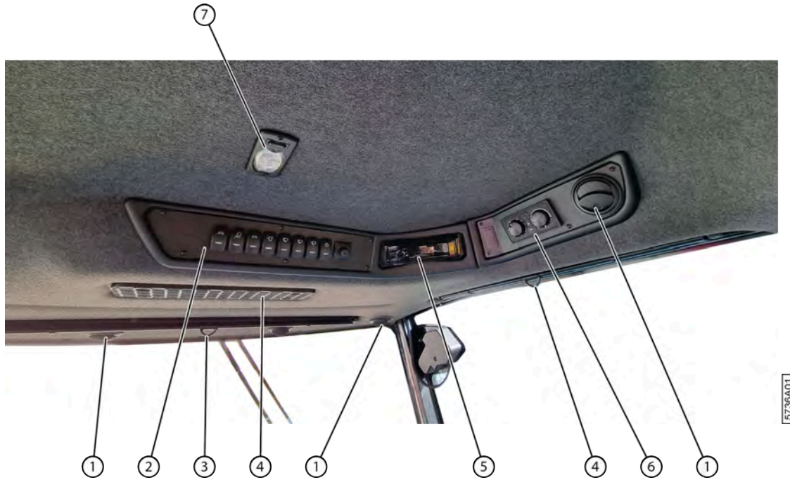
Fig. 17: Éléments sur le toit de la cabine
